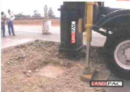
Mini Dynamic Compaction
